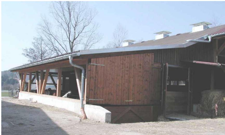
Bild 3: Anbau einer eingestreuten Liegefläche an einen ehemaligen Vollspaltenstall durch Dachanschleppung. Mit Hilfe einer Rampe kann mit Frontlader entmistet werden.
