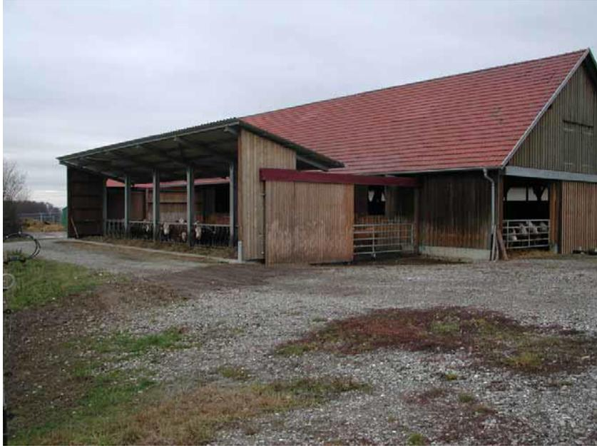
Bild 4: Nutzung einer alten Scheune als Liegehalle an die ein Aussenfressplatz mit Laufhofbereich angegliedert wurde (Mehrraumlaufstall).
